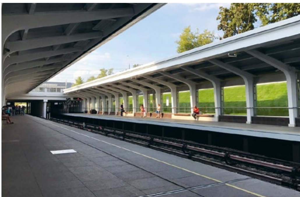
Станция метро «Фили» после реконструкции
